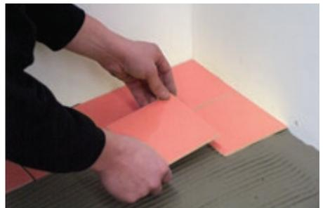
Luego aplique una capa sólida de adhesivo de baldosas flexible procurando evitar la formación de burbujas de aire y use una llana de plástico para no dañar al SRE FHMx-N. (¡NO MANCHE LA BALDOSA!)
